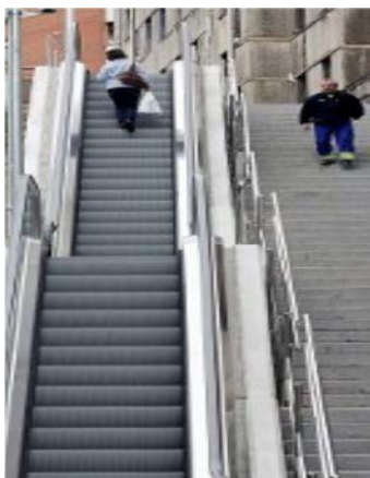
Escaleras mecánicas de Solokoetxe
